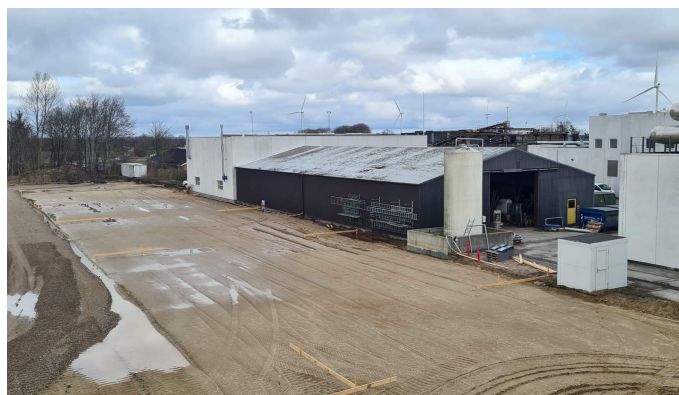
Byggeriet til den nye fabrik er gået i gang
